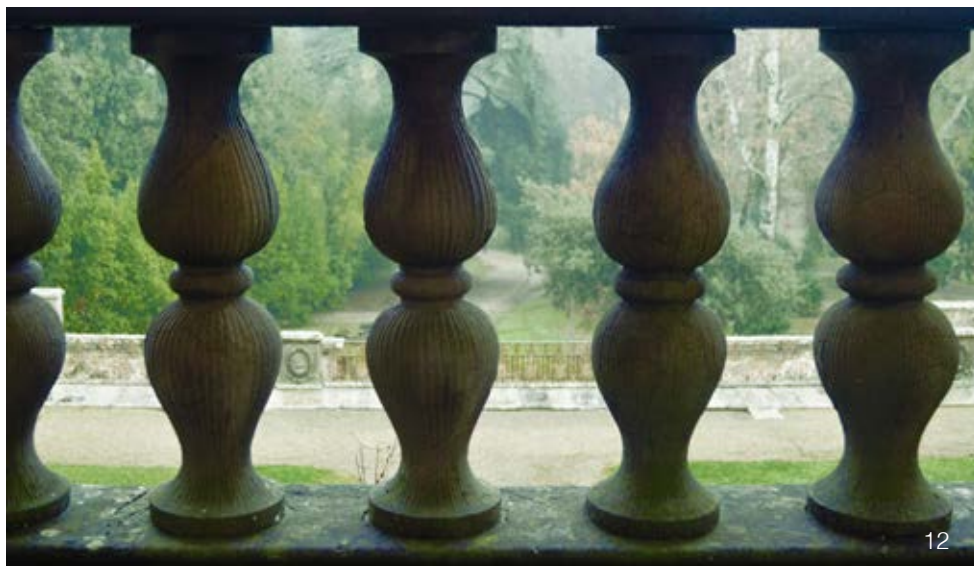
12 Balastra della facciata retrostante Crediti: Architetto Stefano Falcini
